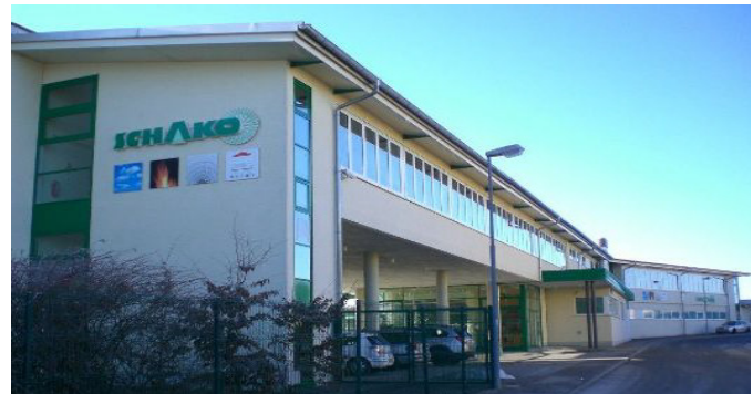
Standort SCHAKO Messkirch
